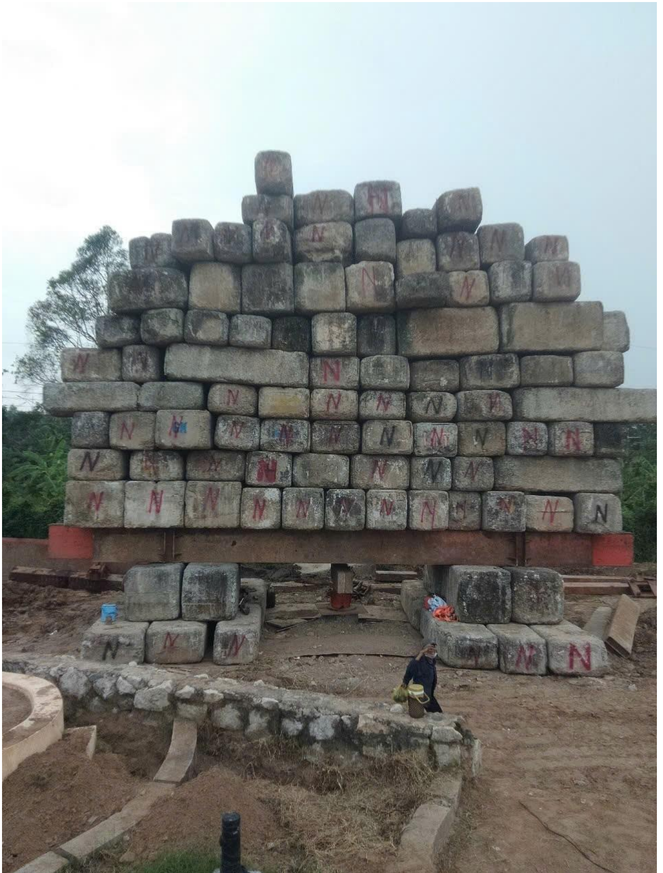
THÍ NGHIỆM NÉN TĨNH CỌC 700 TẤN
