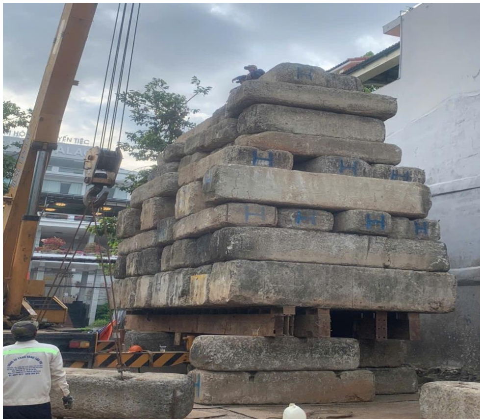
THÍ NGHIỆM NÉN TĨNH CỰC KHOAN NHỒI 350 Tấn
