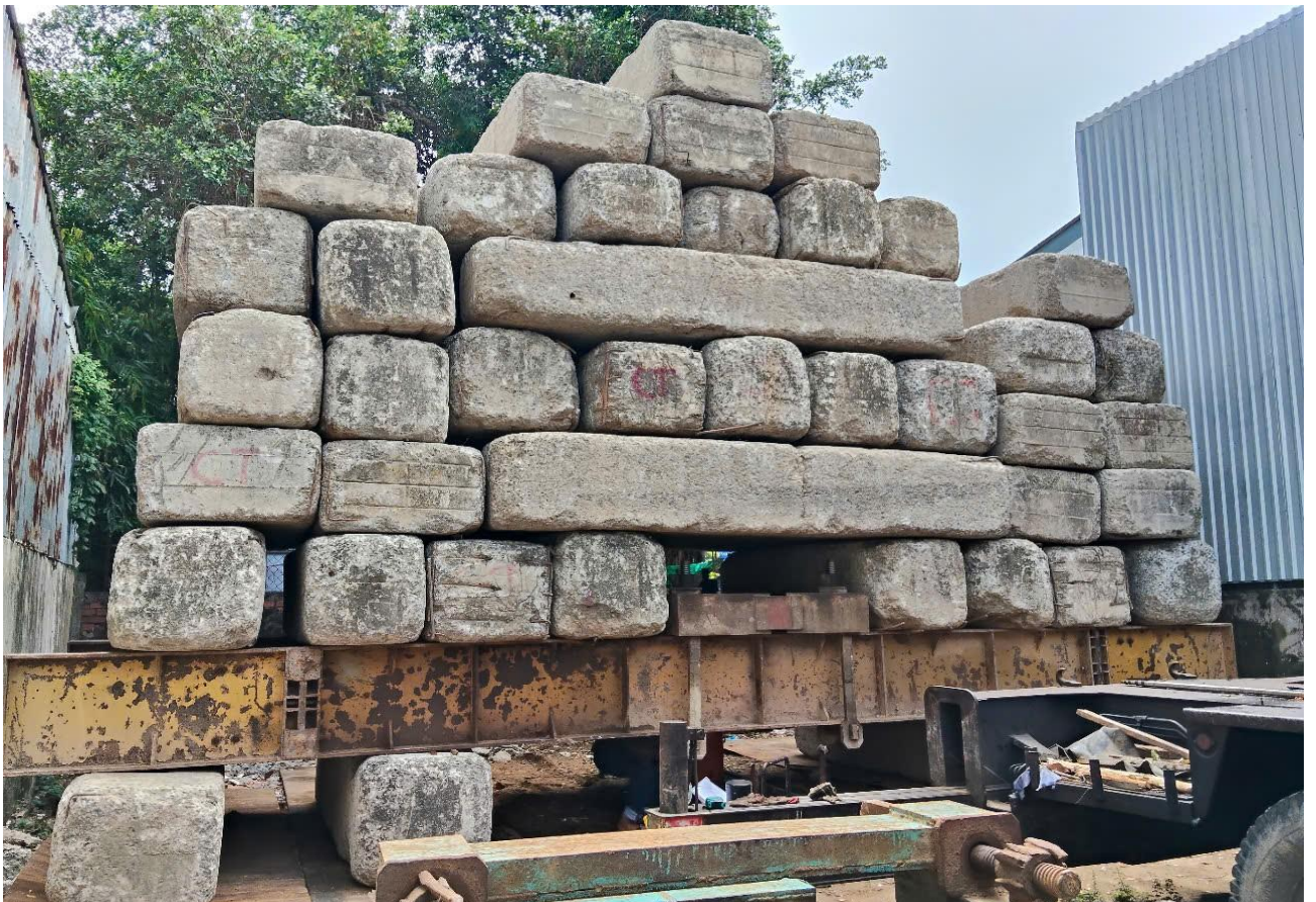
THÍ NGHIỆM NÉN TĨNH CỘC 260 Tấn
