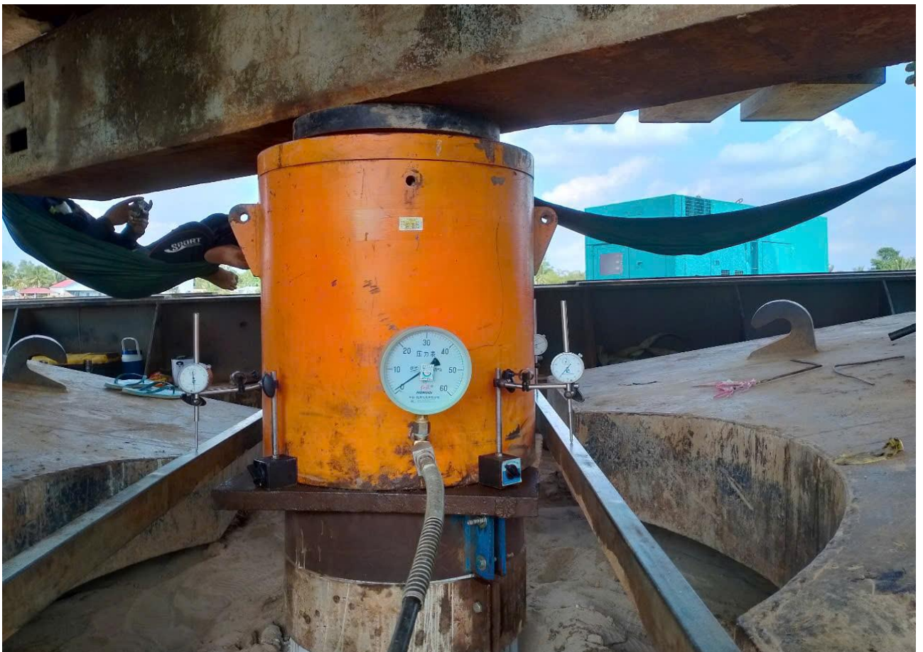
THÍ NGHIỆM NÉN TĨNH CỌC 500 TẤN
